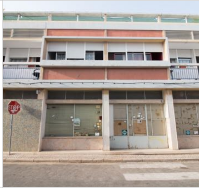
5. Moradias geminadas com espaço comercial Rua Rua Dr. Miguel Bombarda / Rua Seb. Leiria Arquitecto: Manuel Gomes da Costa 1956
